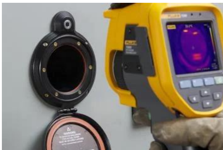
Figura 37: Exemplo de aplicação de janela de inspeção termográfica.
