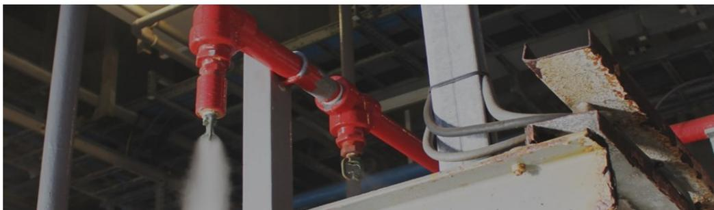
Figura 6: Teste de dilúvio a seco, utilizando fluido gasoso.
