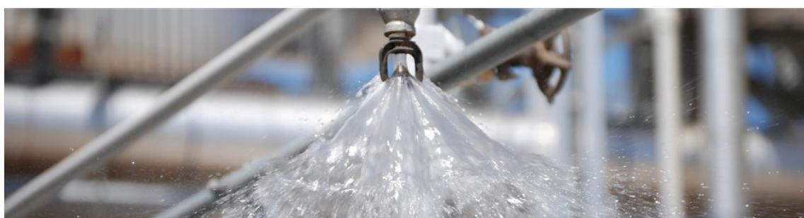
Figura 5: Teste molhado do dilúvio
