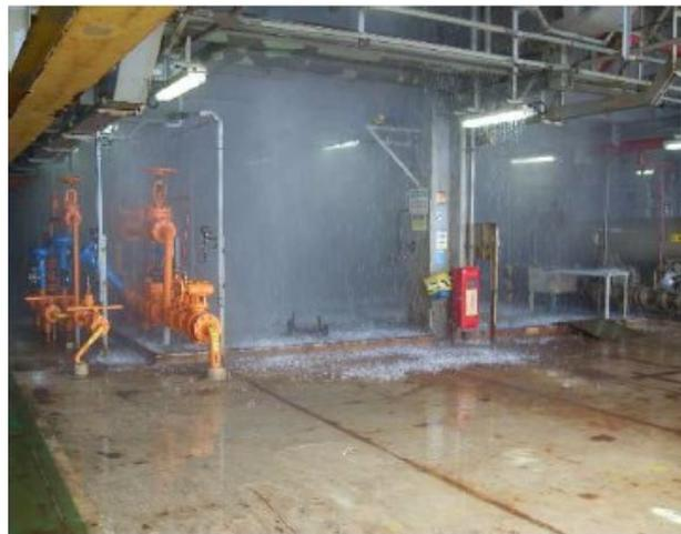
Figuras 1 e 2: Sistemas fixos de combate a incêndio por dilúvio
